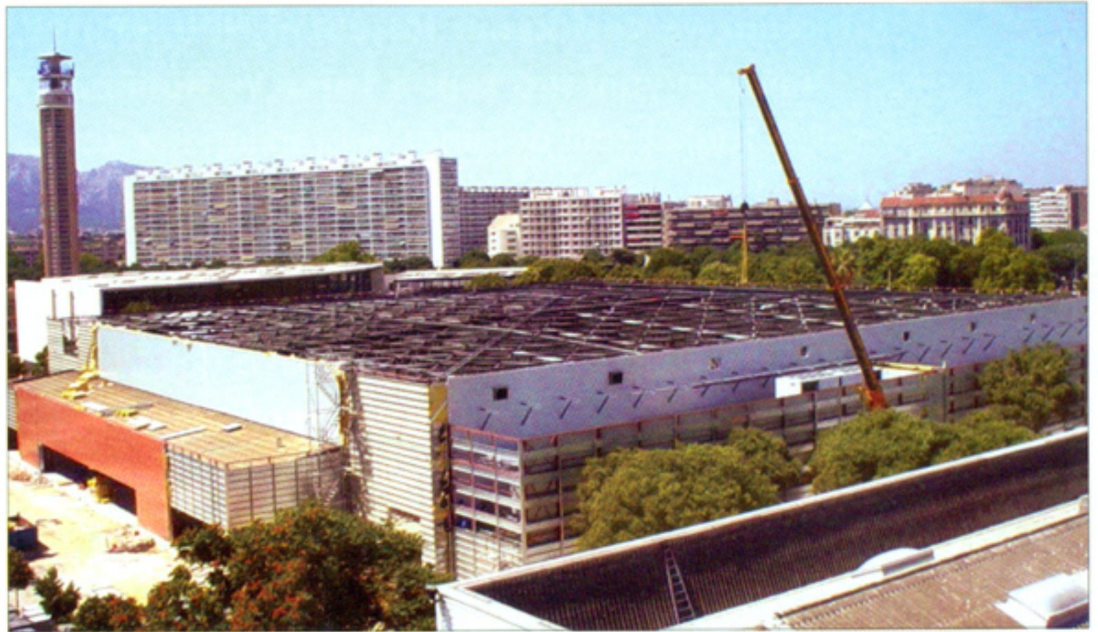
Şekil 1 : Parc Chanot Fuar ve Sergi Salonu, Marsilya / Fransa - Yapının Kaplama Öncesi Genel Görünüşü
