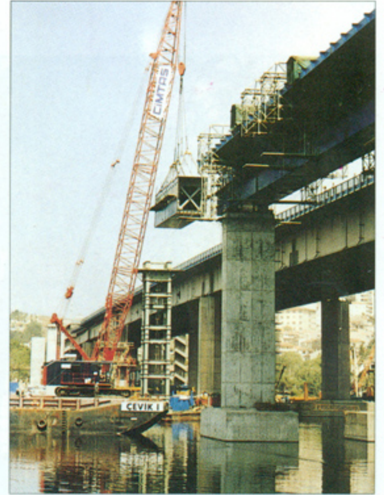
Haliç Köprüsü montaj aşaması
