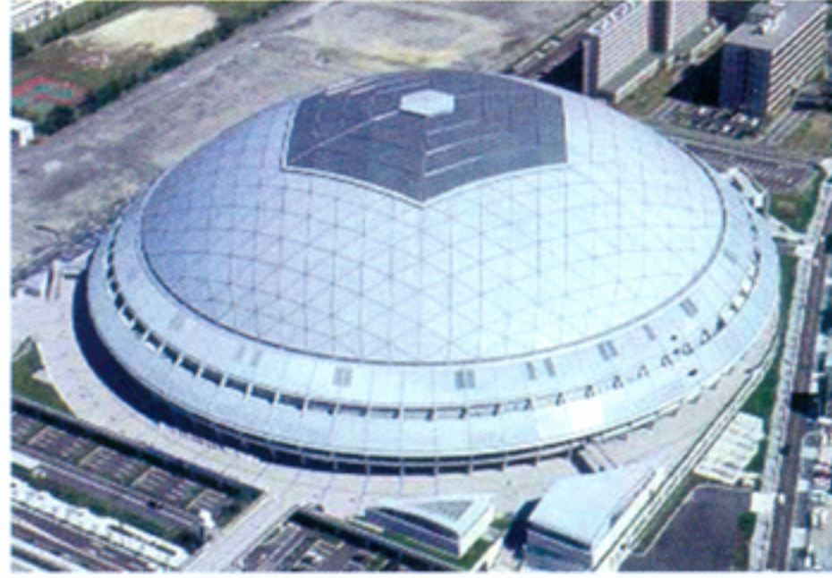
Şekil - 7 Nagoya Dome: Dış Görünüş
