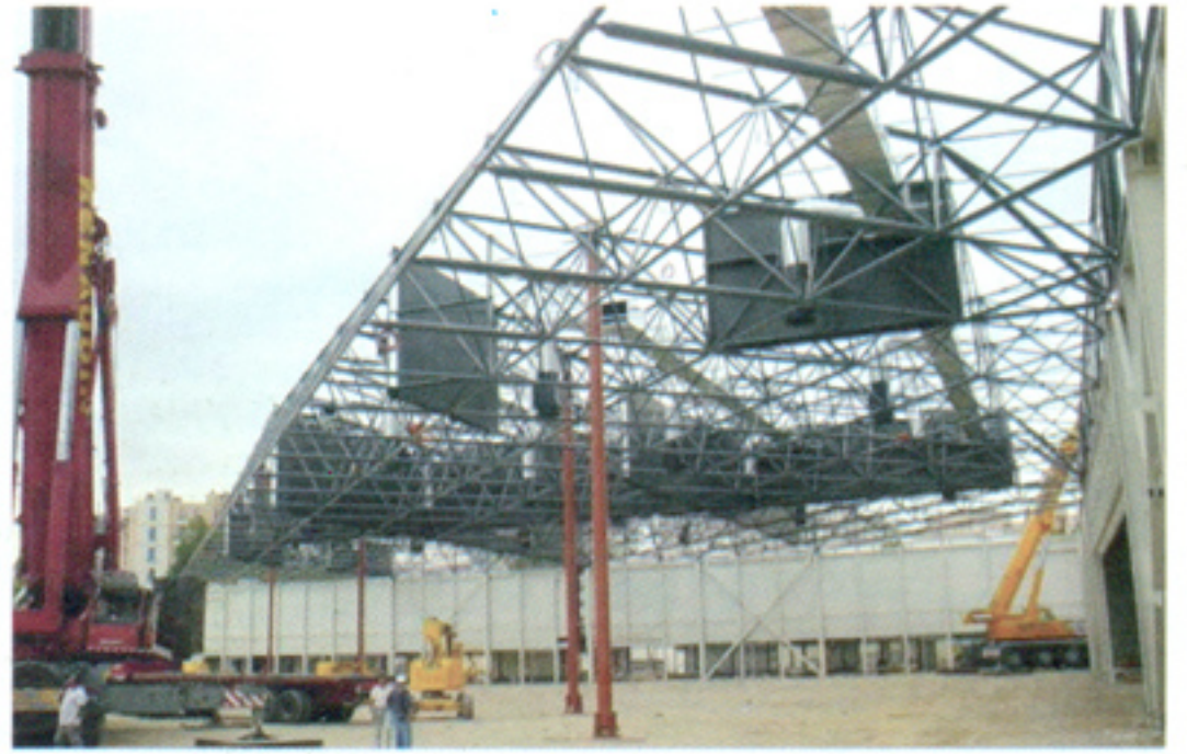
İlk Parçanın Geçici Dikmelere Oturtulması
