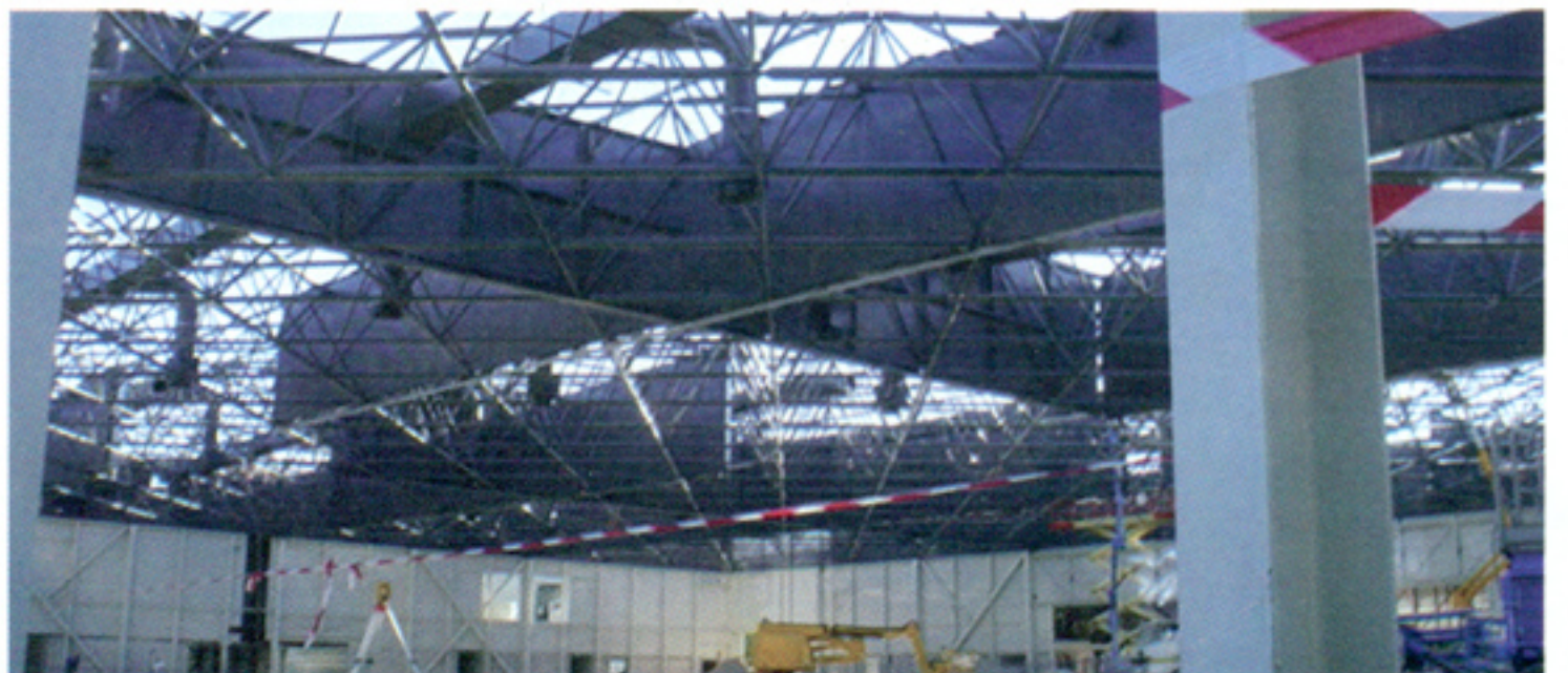
Ara Boşlukların Tamamlanması ve Montaj Sonu
