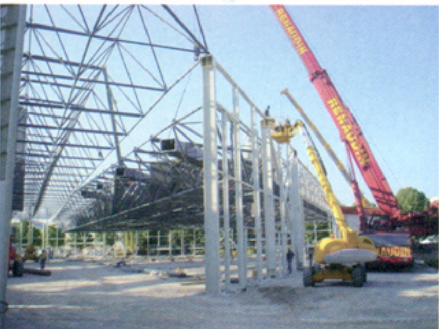
İkinci Parçanın 3 Vinç Yardımıyla Kaldırılması
