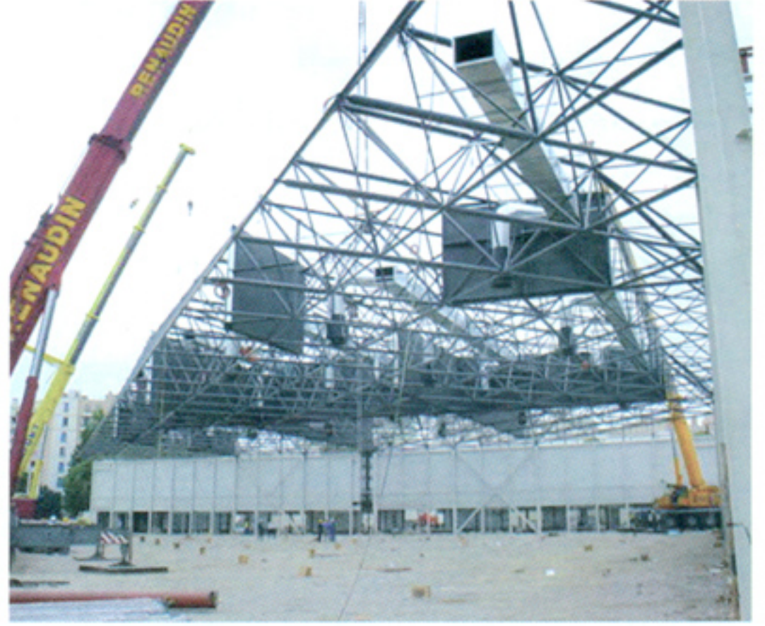
İlk Parçanın 3 Vinç Yardımıyla Kaldırılması
