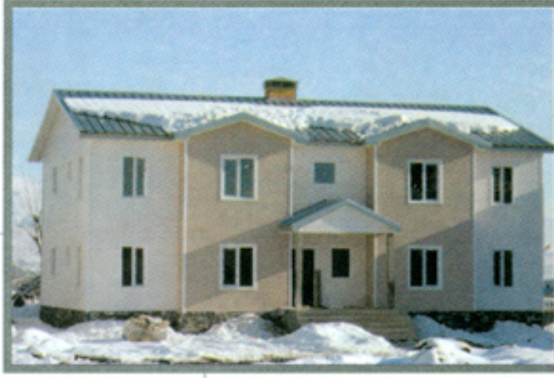
TBMM Vakfı İlköğretim Lojmanı, Bingöl
