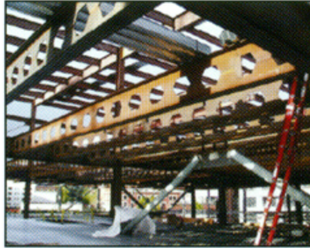
Resim 4: Katlı otopark yapısı, (Atlanta, 2000)
