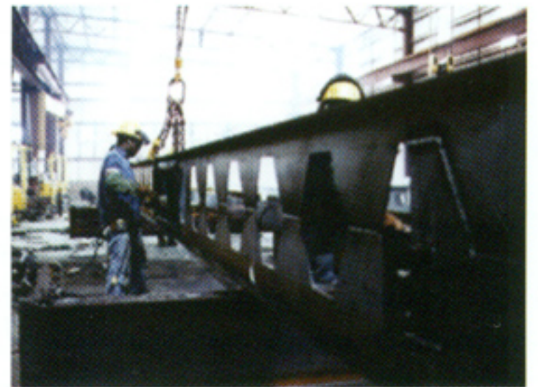
Resim 8: Kaynaklama işleminin elle yapılması
