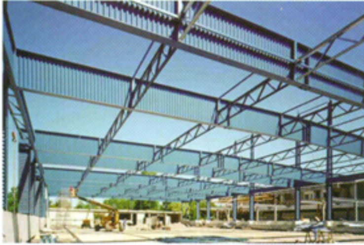
Şekil -1 Büyük açıklıkların dalga gövdeli kirişler ile geçildiği bir spor merkezi
