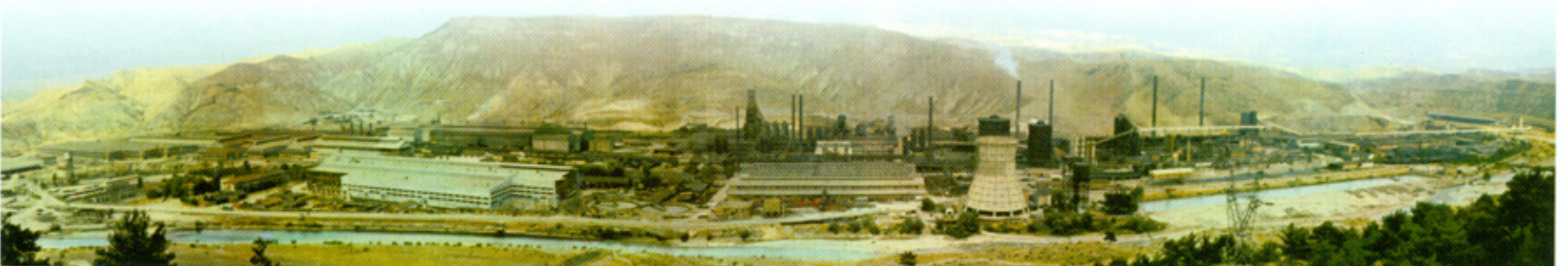
Karabük Demir Çelik Fabrikası
