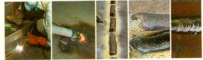
Resim 7. Elektrot kaynağı uygulaması
