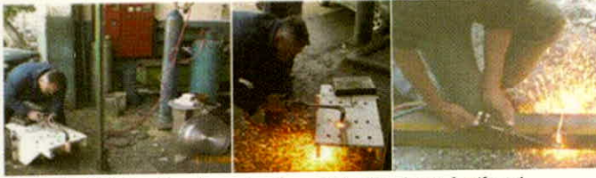
Resim 3. Oksi-Asetilen kaynağı ile metal parçaların kesilmesi
