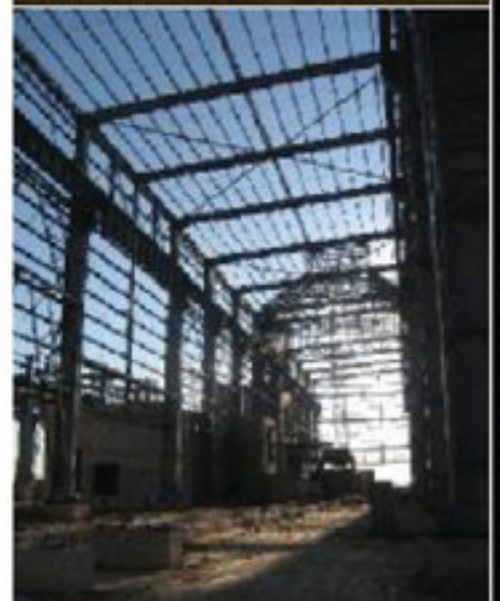
Demisan çelik üretim tesisi Kazablanka - MOROCCO
