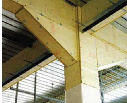
Şekil 14. Plakalarla korunmuş çelik taşıyıcı elemanlar (20)
