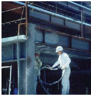
Şekil 11. Püskürtme sıva uygulaması
