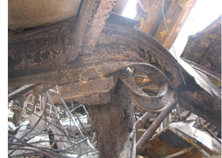
Şekil 5. Çelik yapı elemanlarının yangın anındaki davranışı.
