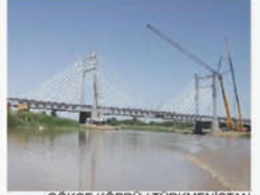
GÖKÇE KÖPRÜ / TÜRKMENİSTAN
