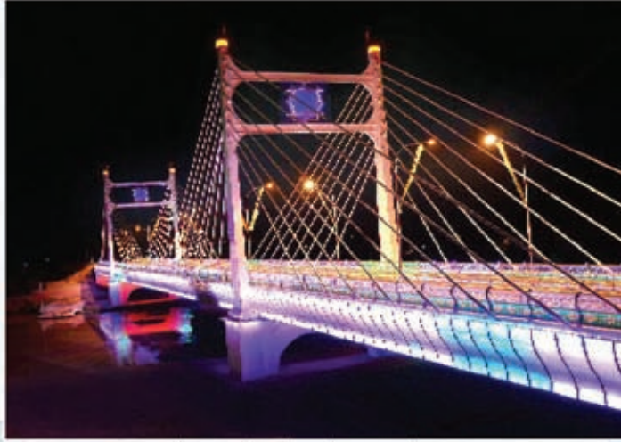
GÖKÇE KÖPRÜ / TÜRKMENİSTAN
