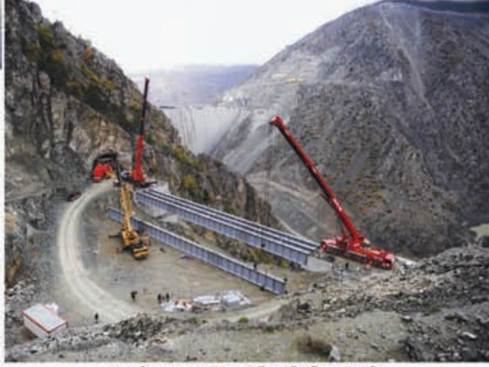
DERİNER OTOYOL KÖPRÜSÜ / ARTVİN
