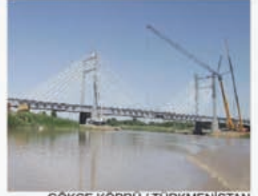
GÖKÇE KÖPRÜ / TÜRKMENİSTAN
