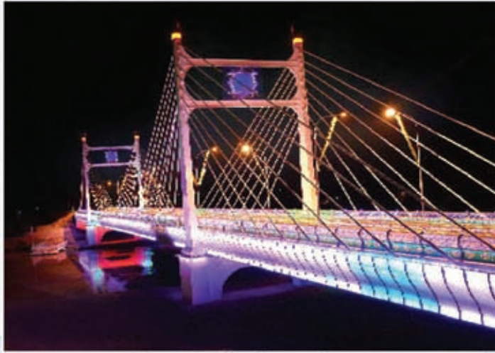
GÖKÇE KÖPRÜ / TÜRKMENİSTAN
