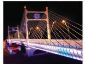
GÖKÇE KÖPRÜ / TÜRKMENİSTAN
