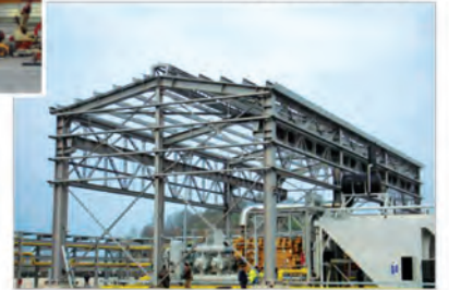
DOĞALGAZ POMPA BİNASI / EREĞLİ
