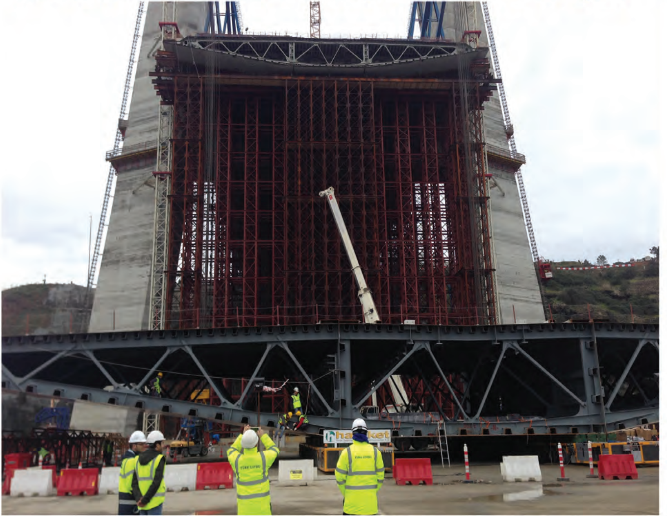
3. BOĞAZ KÖPRÜSÜ E01 NUMARALI ORTHOTROPIC DECK MONTAJI
