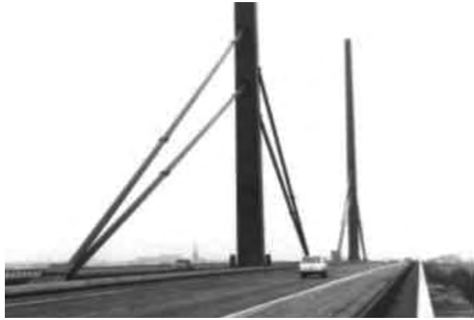
Şekil 21. İlk Norderelbe Köprüsü
