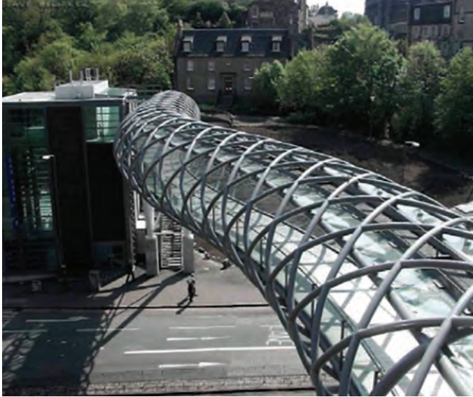
Şekil 3. Greenside Place Köprüsü
