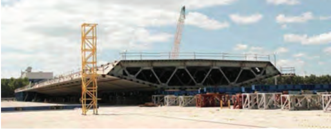
Şekil 8. Deneme montajı için Türkiye'deki ÇİMTAŞ imalat sahasında depolanan köprü tabliye segmanları
