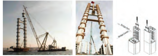
Şekil 14. Kule montajı. Blok montajı (No.1 - 11), panel montajı (No.12 - 22)
