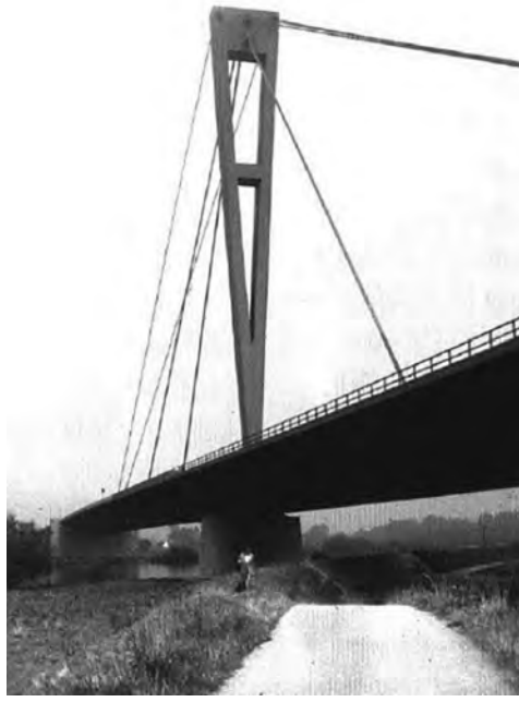
Şekil 23. Yapısal olarak yanlıştır konfigürasyona sahip pylon
