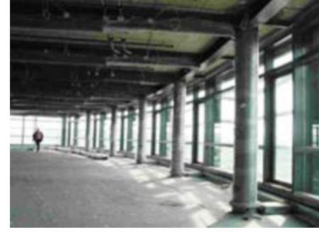
Resim 9. A Bloкта cephenin gerisine yerleştirilmiş olan kompozit çelik kolonlar
