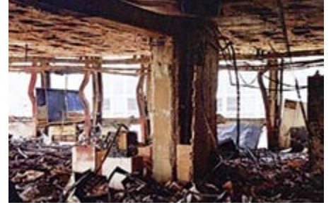
Resim 5. Korumasız çevresel çelik kolonların yangın sırasında burkulması (9. Kat)
