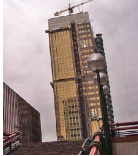
Resim 2. Windsor Tower Binası
