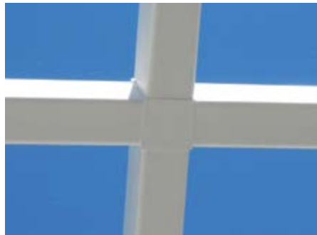
Dörtgen Cam Panel için Konvansiyonel Node
