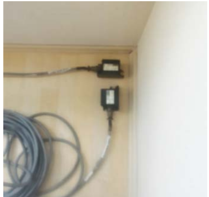
Resim-3. 3 ve 4 numaralı sensörlerin montajı (örnek)
