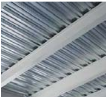
Şekil 5 - Kompozit döşeme elemanı olarak trapezoidal katlanmış sac
