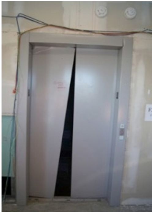
Resim 5 – Sarsma Testleri Sonrası Yapısal/Yapısal Olmayan Hasar Görselleri
