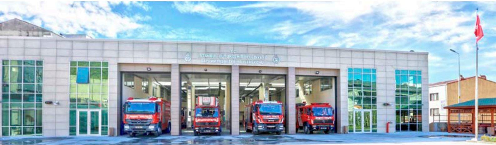
Bayrampaşa Altıntepsi Mahallesi İtfaiye Binası
