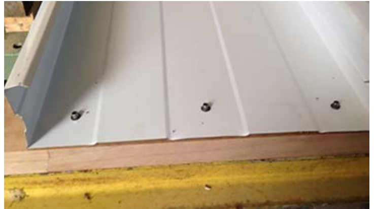
Şekil 15 - Birbirine bağlı üç iç kaplama levhası kullanılan düzenleme
