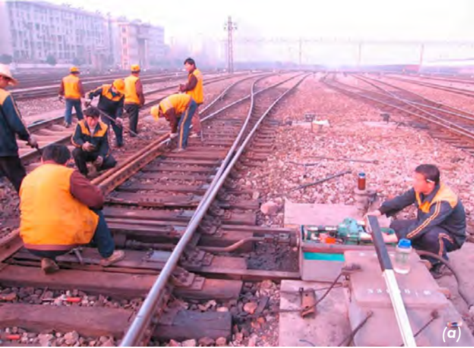
Şekil 8 - (a) Wuhan ÇİN Demir yolu makaslarında lazer ısıtma işlemi için çalışmalar (b) İşlem sonrası makaslar
