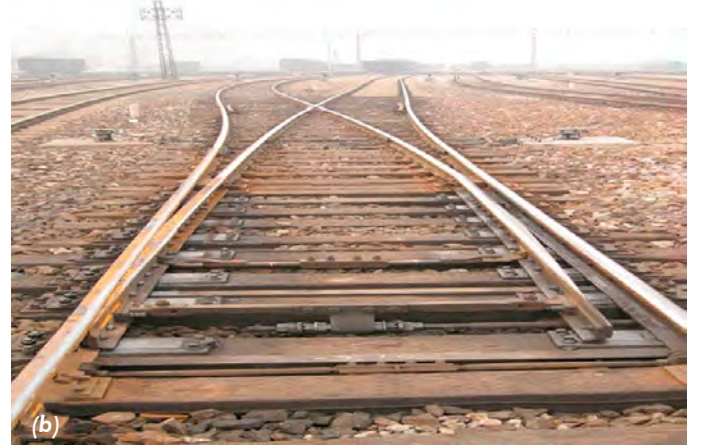
Şekil 8 - (a) Wuhan ÇİN Demir yolu makaslarında lazer ısıtma işlemi için çalışmalar (b) İşlem sonrası makaslar
