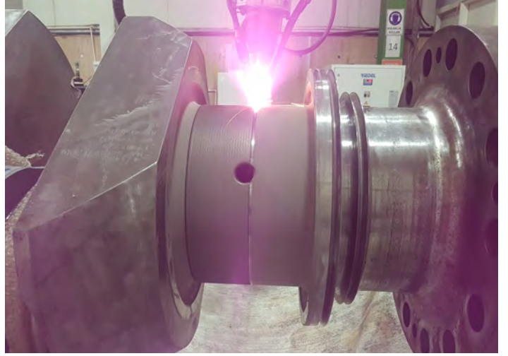
Şekil 18 - Gemi motoru hasarlı krank mili onarımı
