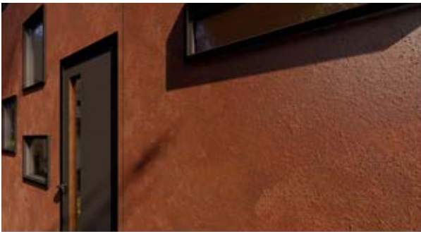
CEPHE TASARIMI DİŞ CEPHE MALZEMESİ KÖR-TEN ÇELİK OLARAK TERCİH EDİLMİŞ VE DÜNYANIN HER BÖLGESİNDEKİ HAVA ŞARTLARINA UYAN VE OKSİTLENEN YAPISIYLA ÇEVRESİNE UYUM SAĞLAYABİLEN DOKUSUYLA SÜRDÜRÜLEBİLİR OLMASI HEDEFLENMİŞTİR. TASARLANAN PENCERELER YAPI İÇERİSİNDEKİ BİRİMLERİN UYGUN İĞİİ ALABİLMESİ VE HAVA SİRKÜLASYONUNUN SAĞLIKLI OLABİLMESİ İÇİN BELİRLİ BİR DÜZENDE YERLEŞTİRİLMİŞTİR.
