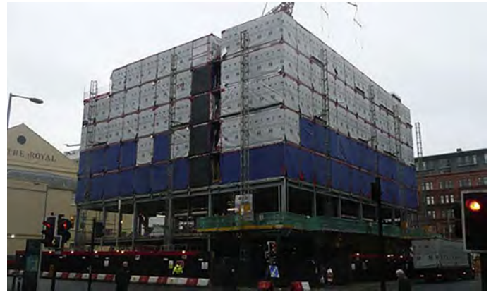
Şekil 25. Hazırlanan modüllerin podyum üzerine montajı (Smith, 2011)
