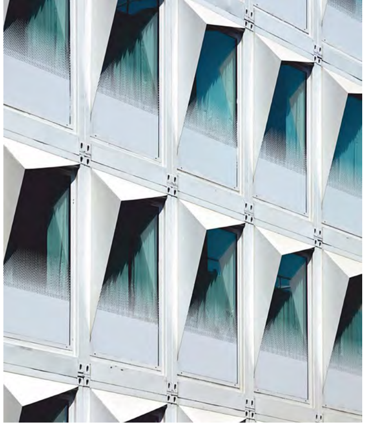
Şekil 21. Cadde cephesindeki çelik saç paravanlar ile yarıya kadar beyaz baskılı camlar mahremiyet ve gölgeleme sağlamaktadır (Kerr, 2020)
