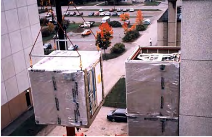
Şekil 12. Yarı açık tesisat modülünün yerleşimi (Lawson, 2007)
