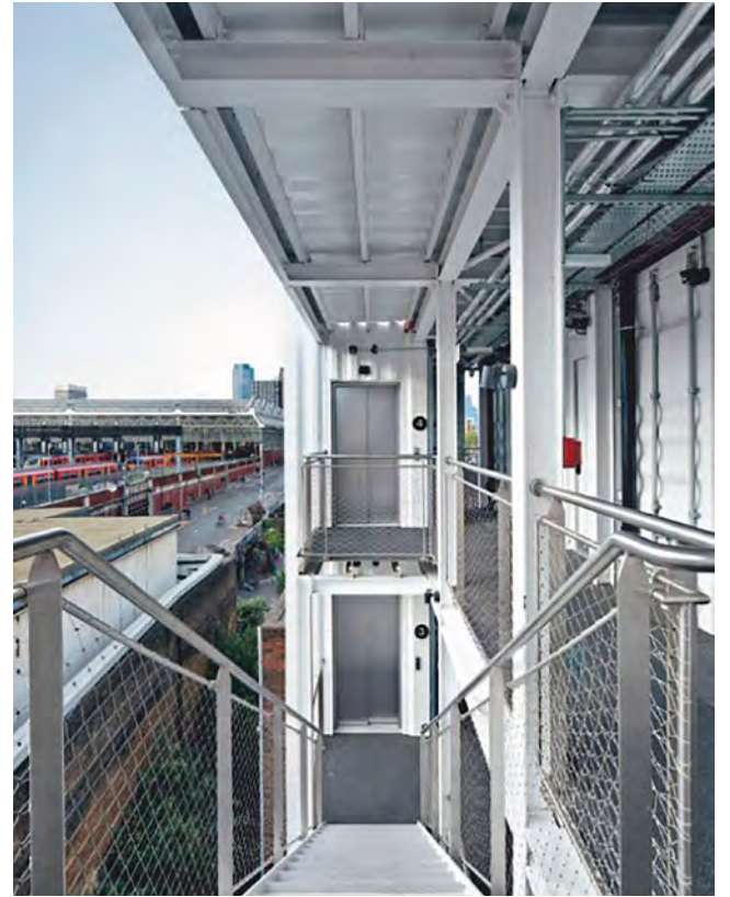
Şekil 22. Üst katlardaki otel odalarına erişim, balkonları, merdivenleri ve asansörü olan çelik bir strüktür ile sağlanmaktadır (Kerr, 2020)
