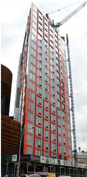
Şekil 15. Modüllerin fabrikada üretimi ve yerine montajı (Generalovaa ve diğ., 2016)
