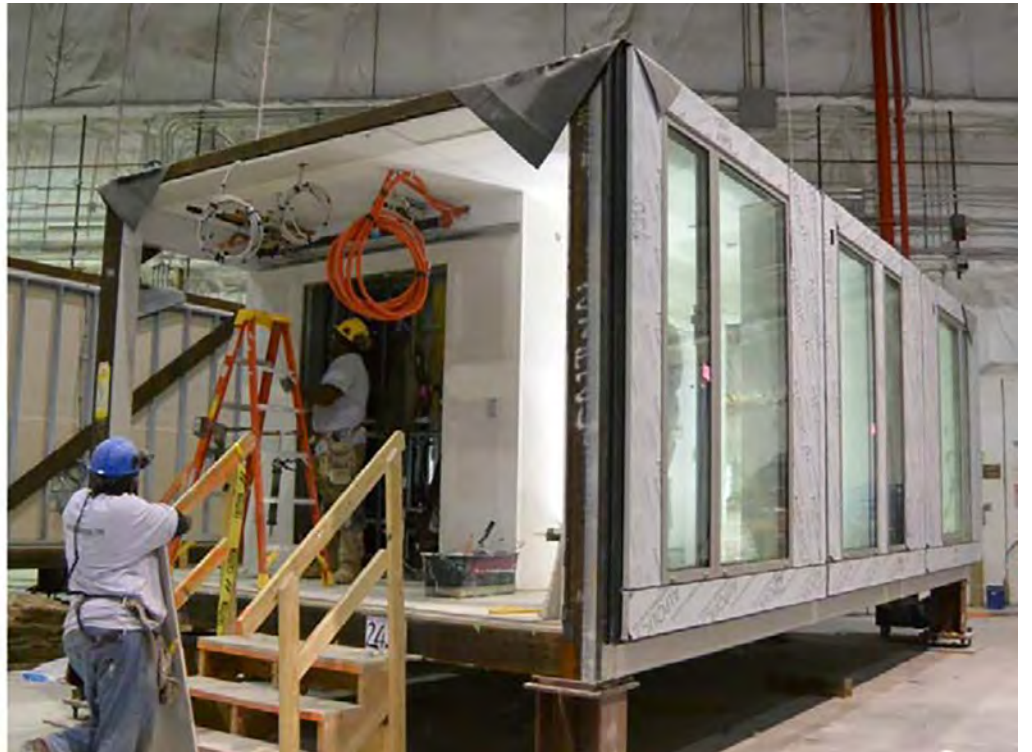
Şekil 15. Modüllerin fabrikada üretimi ve yerine montajı (Generalovaa ve diğ., 2016)
