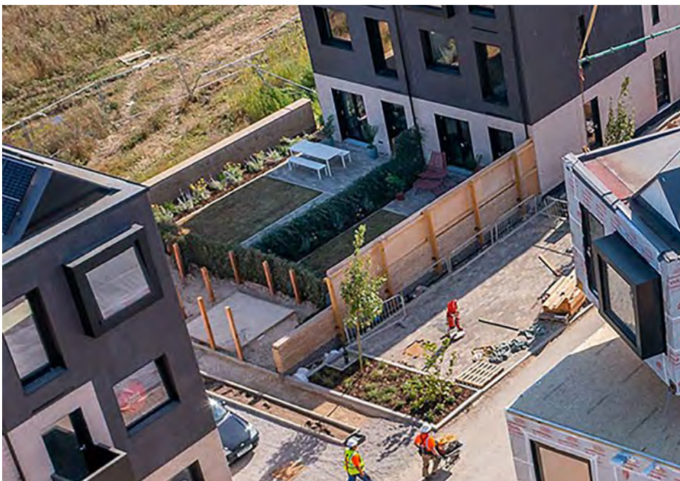
Şekil 8. Yığma sistem modüler konut yapımı (URL - 2)
