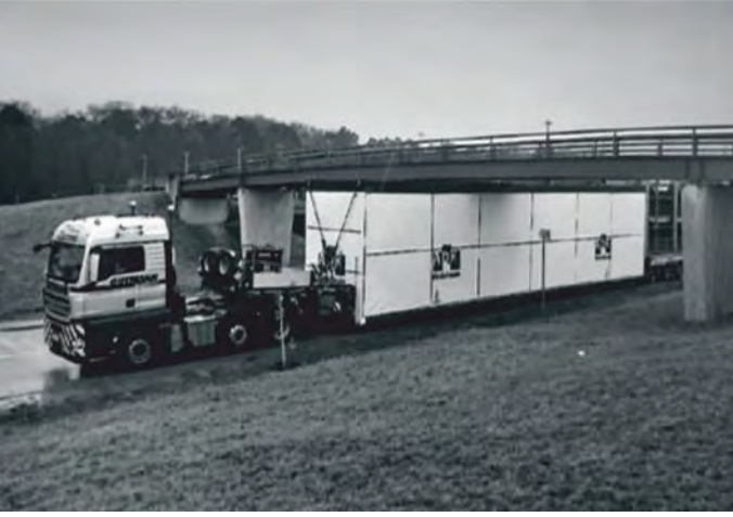
Şekil 32. Modüllerin şantiyeye nakliyesi (Fuchs, 2020)
