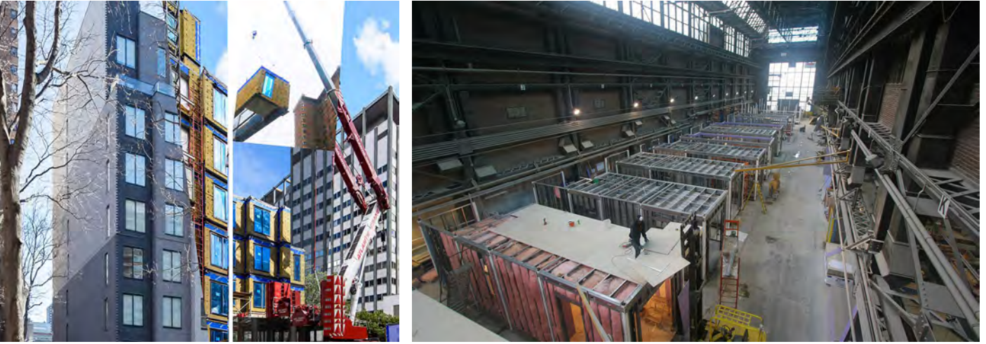
Şekil 19. Modüllerin üretimi ve montajı (URL - 6)
