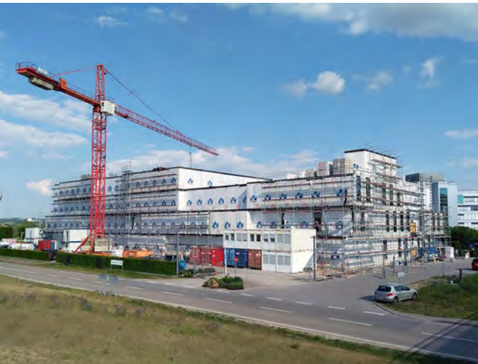
Şekil 33. Modüllerin yerine yerleştirilmesi ve montajı (URL - 7)
