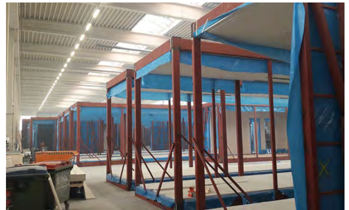
Şekil 31. Modüllerin fabrikada üretimi ve şantiyede montajı (URL - 7)
