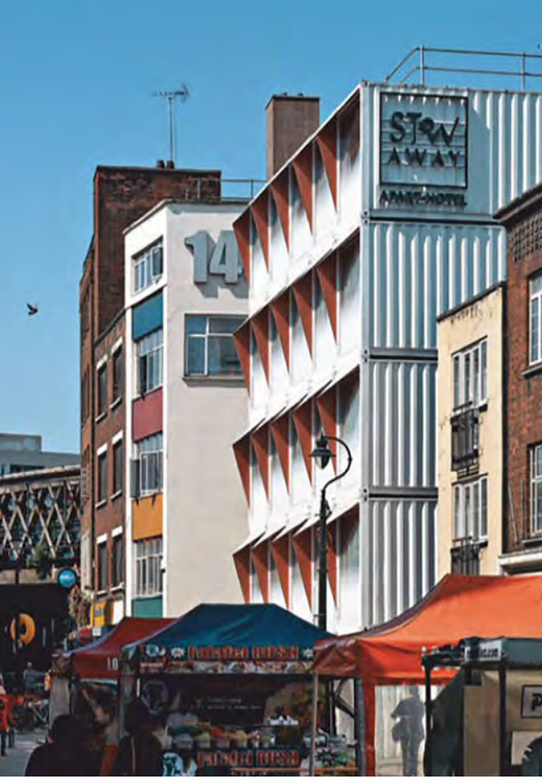
Şekil 21. Cadde cephesindeki çelik saç paravanlar ile yarıya kadar beyaz baskılı camlar mahremiyet ve gölgeleme sağlamaktadır (Kerr, 2020)
