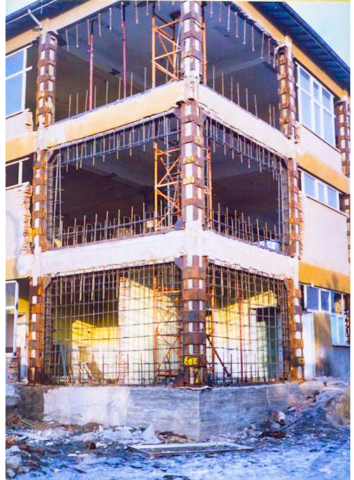
Şekil-1 1992 Erzincan depreminden sonra yapılan güçlendirme
