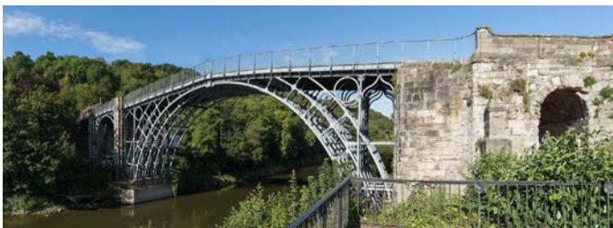
Restorasyon öncesinde köprünün rengi mavi-griydi - 2014 @ Colin
