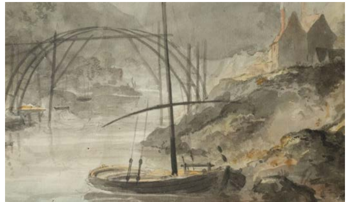
Köprünün, İsveçli ressam Elias Martin tarafından 1779 yılında yapılmış resmi. Bu, köprünün inşası sırasında bilinen tek resimdir
